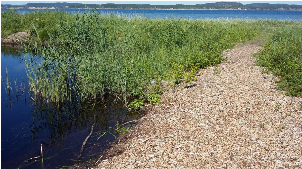
Figur 9. Flisfylling og drenerør mot Evadammen. Foto ES 28.06.2019.
