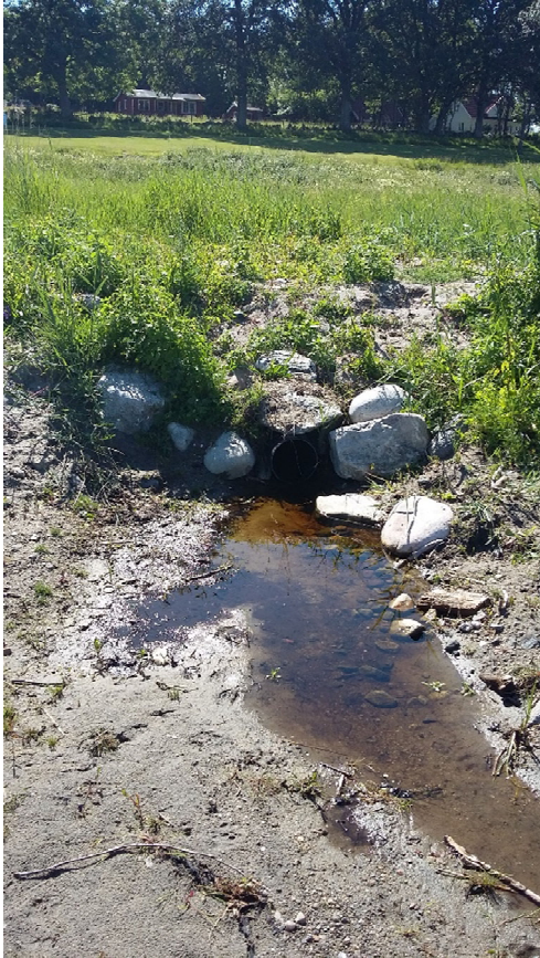
Figur 10. Opparbeida drenering ut mot sjøen fra strandsumpområdet i nord. Foto ES 28.06.2019.
