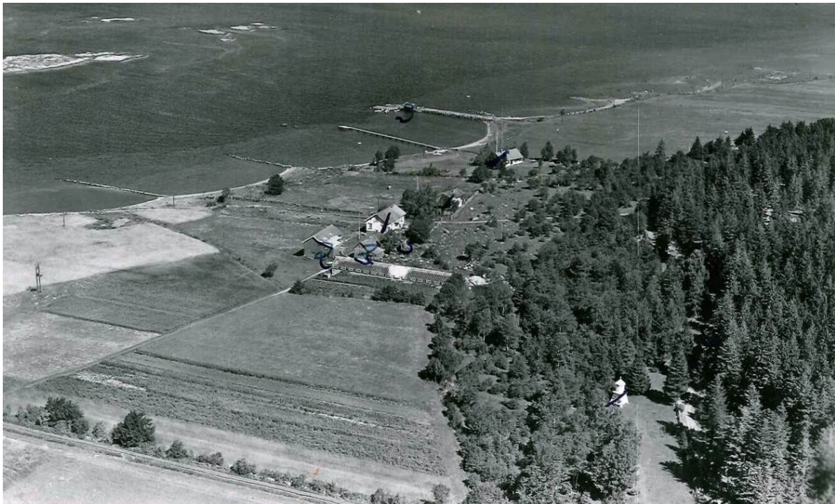
Figur 24. Bildet er tatt fra sør og viser Østre Saltverksmyr midt i bildet. Brygga lengst t.h er Haganebrygga som utgjør de sørligste delene av skjøtselplanområdet. En antar at bildet er tatt på 1960-tallet. Bildet er utlånt av Kragerø kommune.
