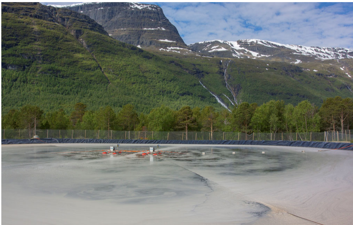
Figur 3. Rensedam sommeren 2019. I løpet av våren 2020 og før sommerens aktive periode vil tilførselsrør og uttaksrør bli flyttet og omrørerne vil bli plassert lenger fra hverandre
