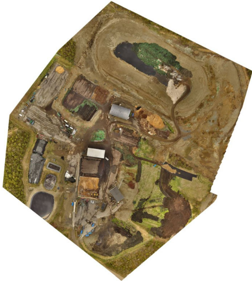
Figur 4. Drone foto over anlegget til ORIGO juni 2018 over og under mai 2019 med ferdig nytt deponi og sigevannsdam. Lett forurenset masser av plast utgjør grønne masser i det nye deponiet (Foto Origo)
