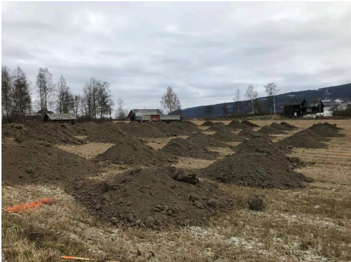
Figur 17. Flyttet topplag i hauger som ble jevnet ut med gravemaskin våren 2020 og sådd til ved normal våronntid (Foto: Erik A. Dahl).
