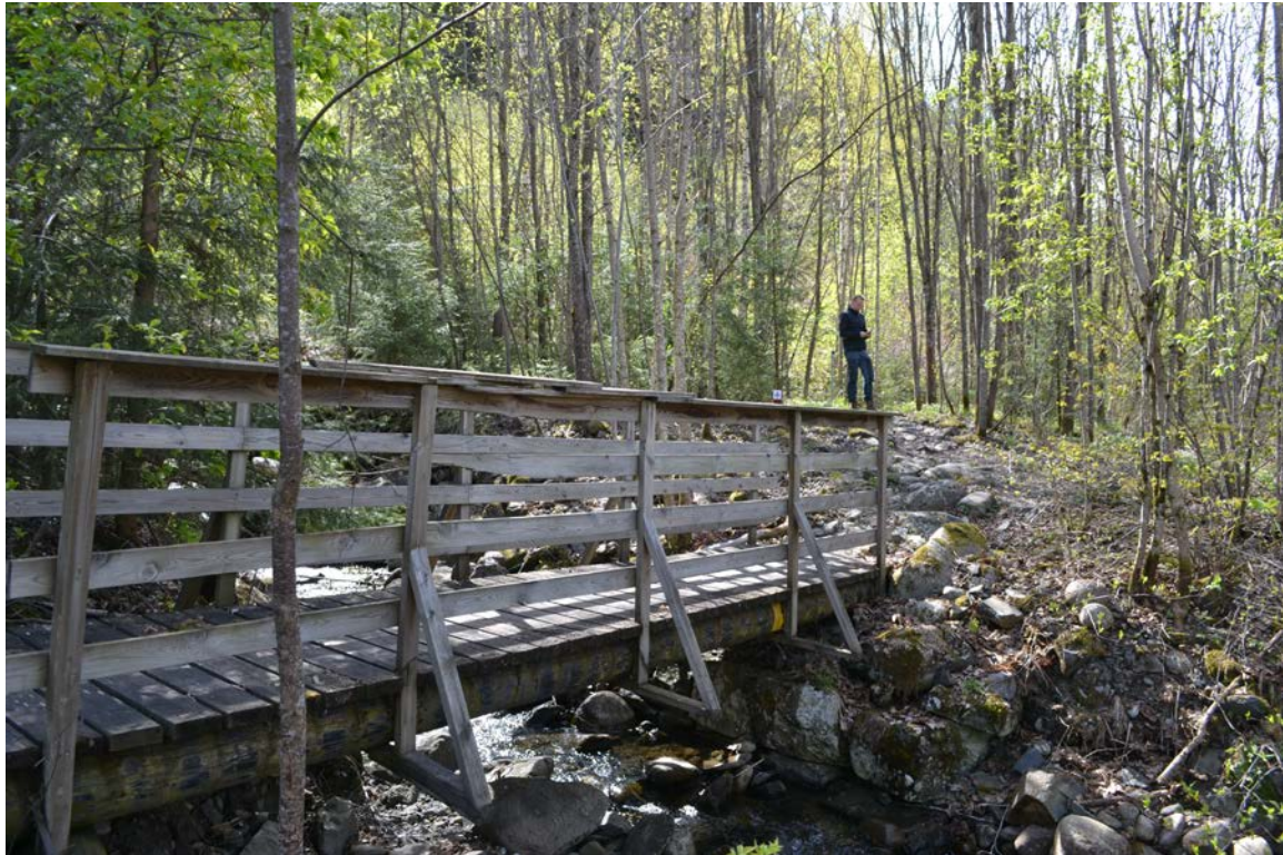
Figur 8. Pilegrimsleden med bru over bekken i område som anbefales urørt av nydyrking.
