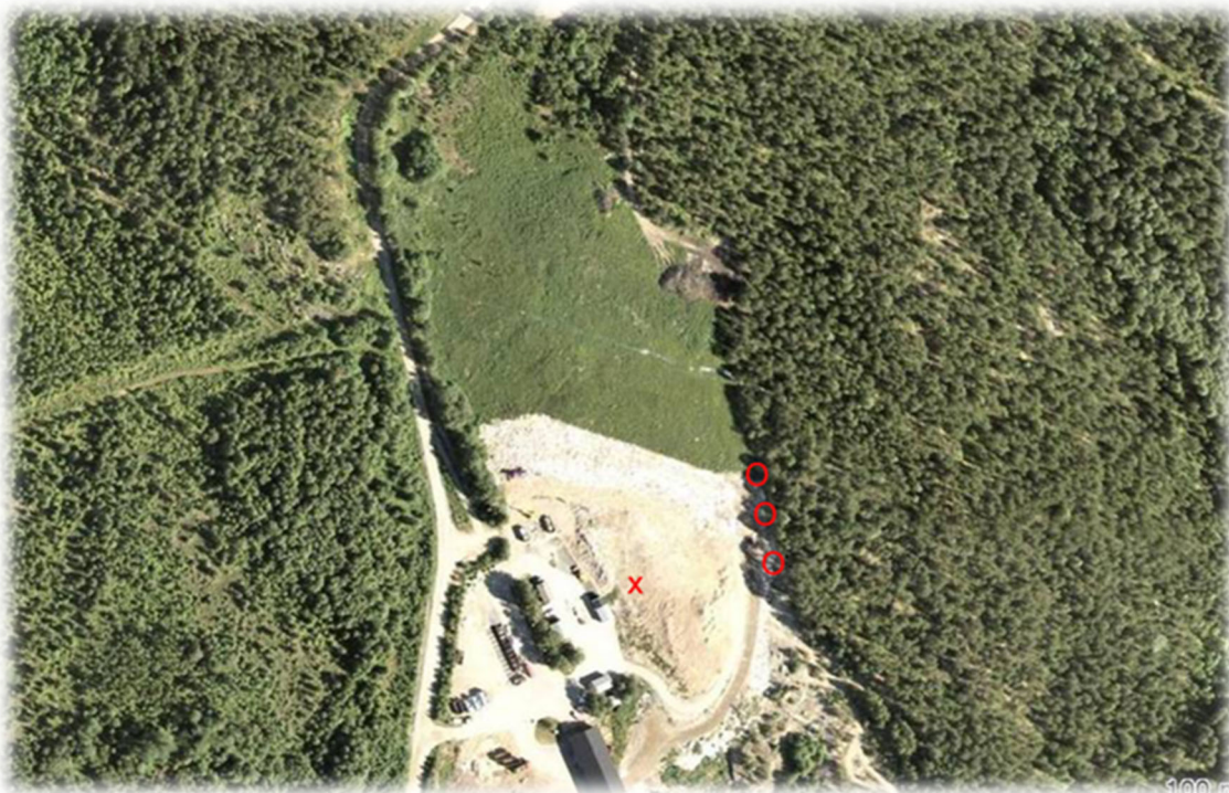
Figur 1. Flyfoto over deponiet på Spillhaug. Kryss viser området hvor det ble målt gass i flukskammer tidligere 2012 og 2013. Åpne ringer viser hvor måling er blitt utført og hvor flere døde trær sto før de ble fjernet.
