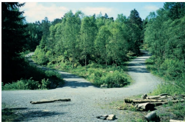
Figur 18. Møteplass. Steinene midt på bildet sikrer hull ved stikkrenne og er kvileplass.
