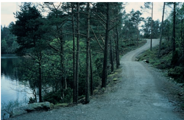
Figur 9. Vegen er lagt nær vatnet. Gjensatte trær lager en kantsone.
