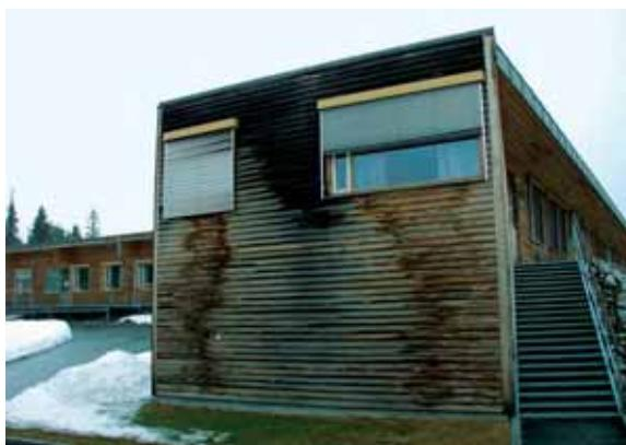
Manglende takutstikk vil gi oppfukting av veggen og dette kan gi soppeskader. (Foto: Mycoteam as)
