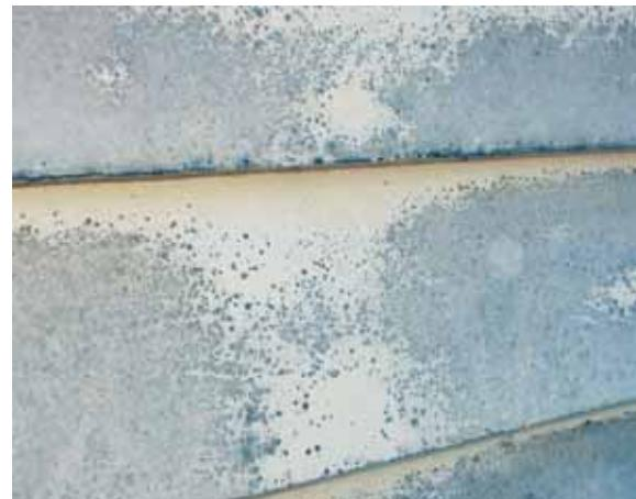
Bilde 5 Svertesoppskade på utvendig kledning. (Foto: Lone R. Gobakken)
