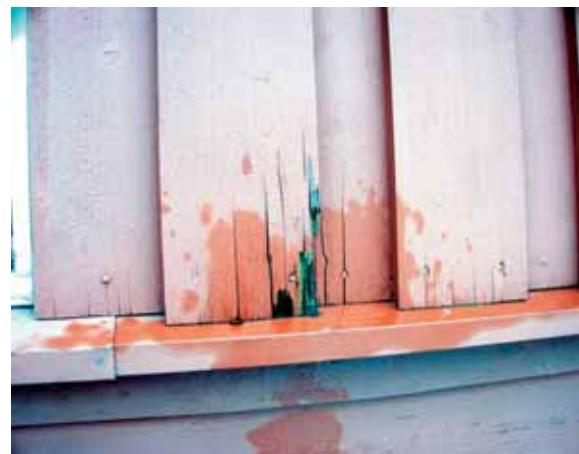
Bilde 4 Råtesoppskade i utvendig kledning. (Foto: Lone R. Gobakken)
