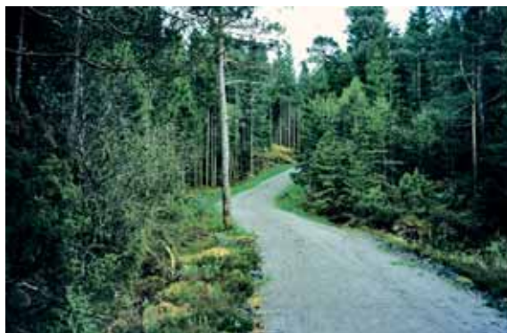
Bilde 1. Mange brukergrupper innen friluftsliv er avhengig av eller begünstiget av skogsveger. Bildet viser en vellykket tilpasning av bilvegen til landskap og friluftsliv. Vegkroppen er anlagt på en underbygning av flis. Hordnes, Bergen. Foto: Hans Nyeggen
