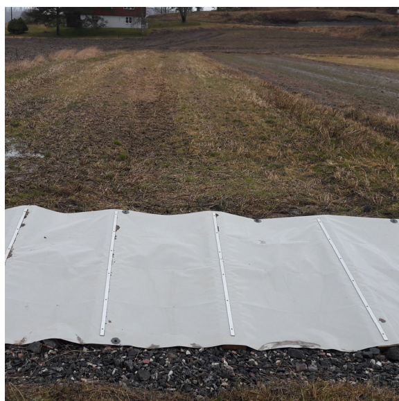
Figur 1.2. Dekke som kan tas av for å rense rennene lagt på høsten 2019
