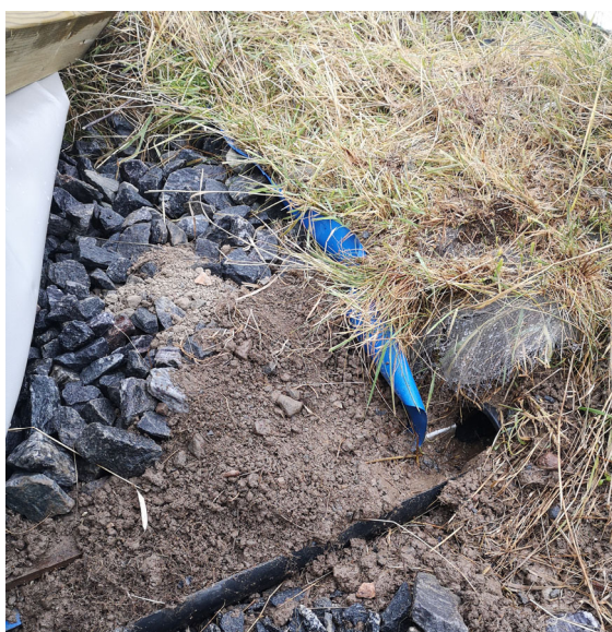
Figur 1.1. Jordrotter graver ut jord i renne for oppsamling av overflatevann – sommeren 2019
