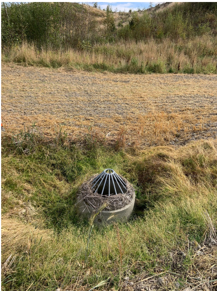
Figur 13. Dagens nedbørskum. Bildet viser tydelig erosjon rundt nedbørskummen og eksponering av røret ned i jorda.
