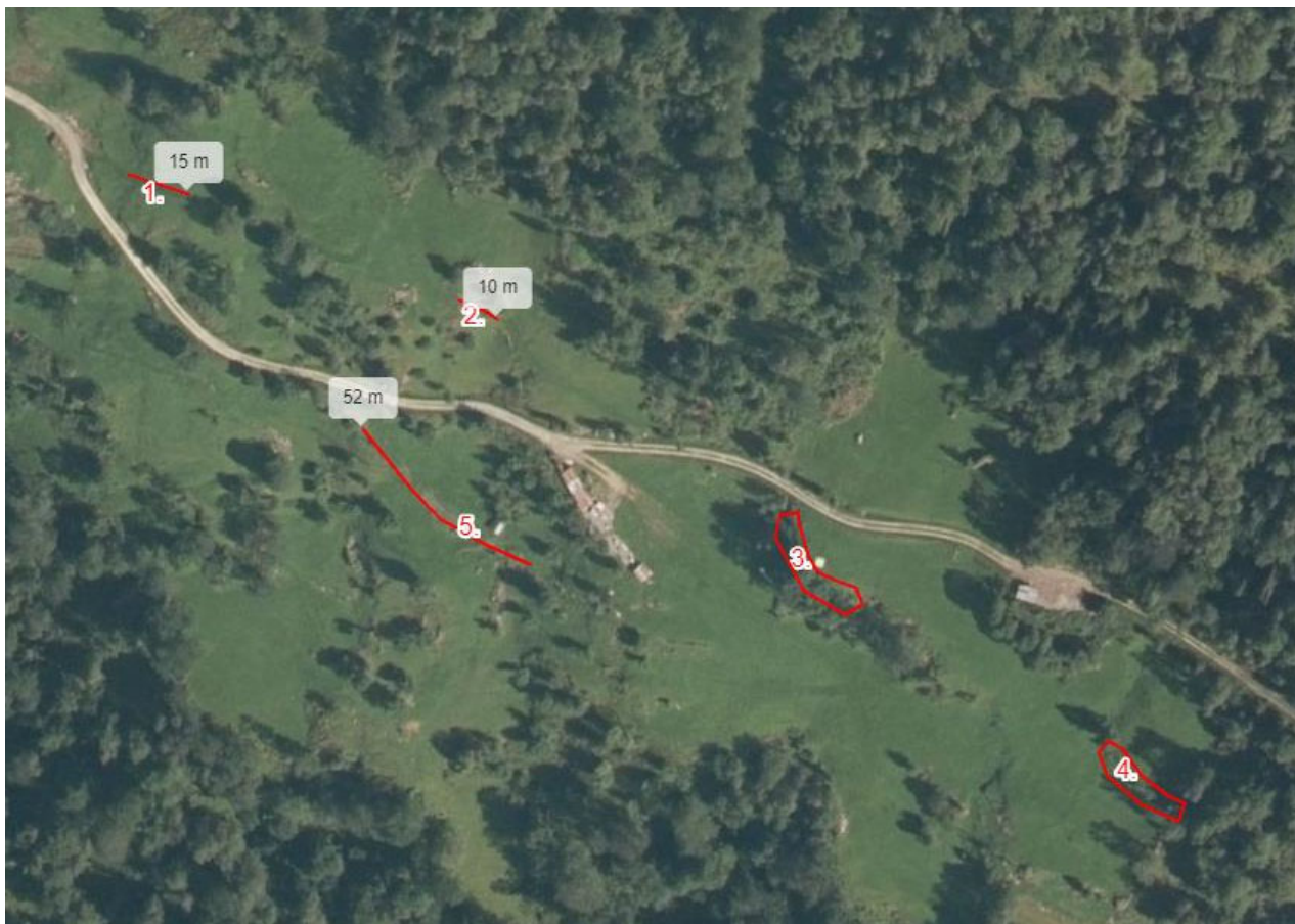
Figur 6. Driftsveggar og bakkemurar som treng vedlikehald/oppgradering på Ulvund. Aktuelle restaureringstiltak for neste planperiode. Nummer viser til tabell i kap 2.9.
