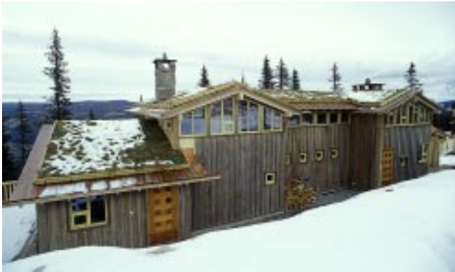
Ubehandlet kledning av ospevirke på hytte på Kvitfjell, Ringebu, Oppland.
