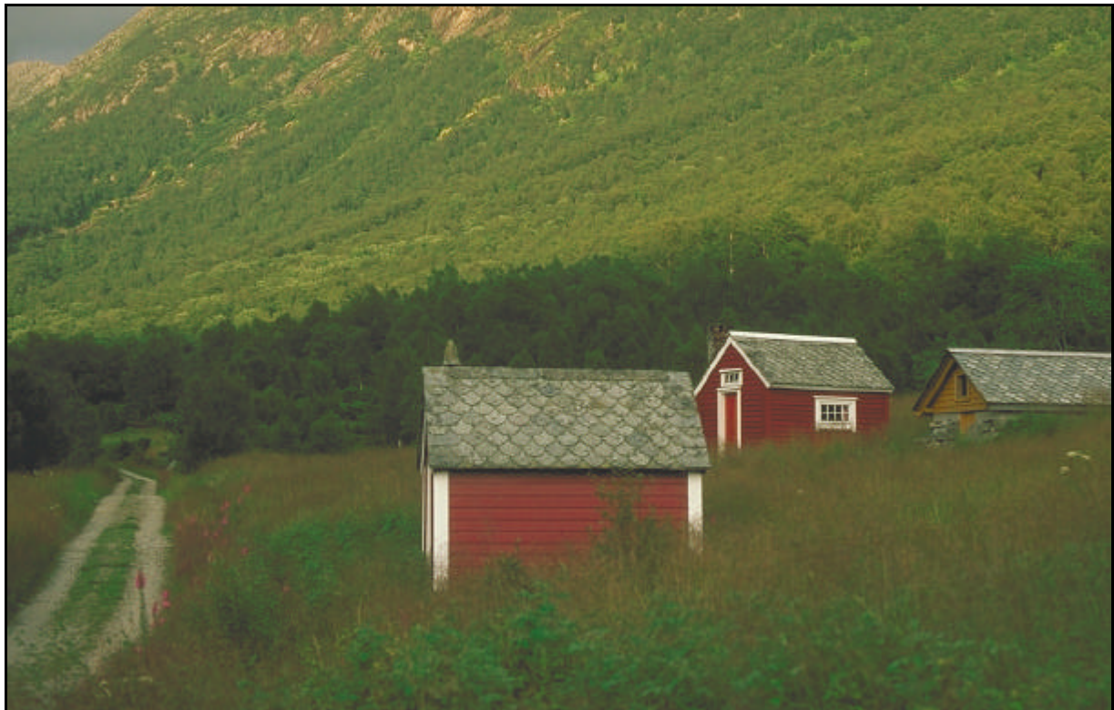
31. Midtsætret. Ikkje drift, men bygningane er stort sett velhaldne.
