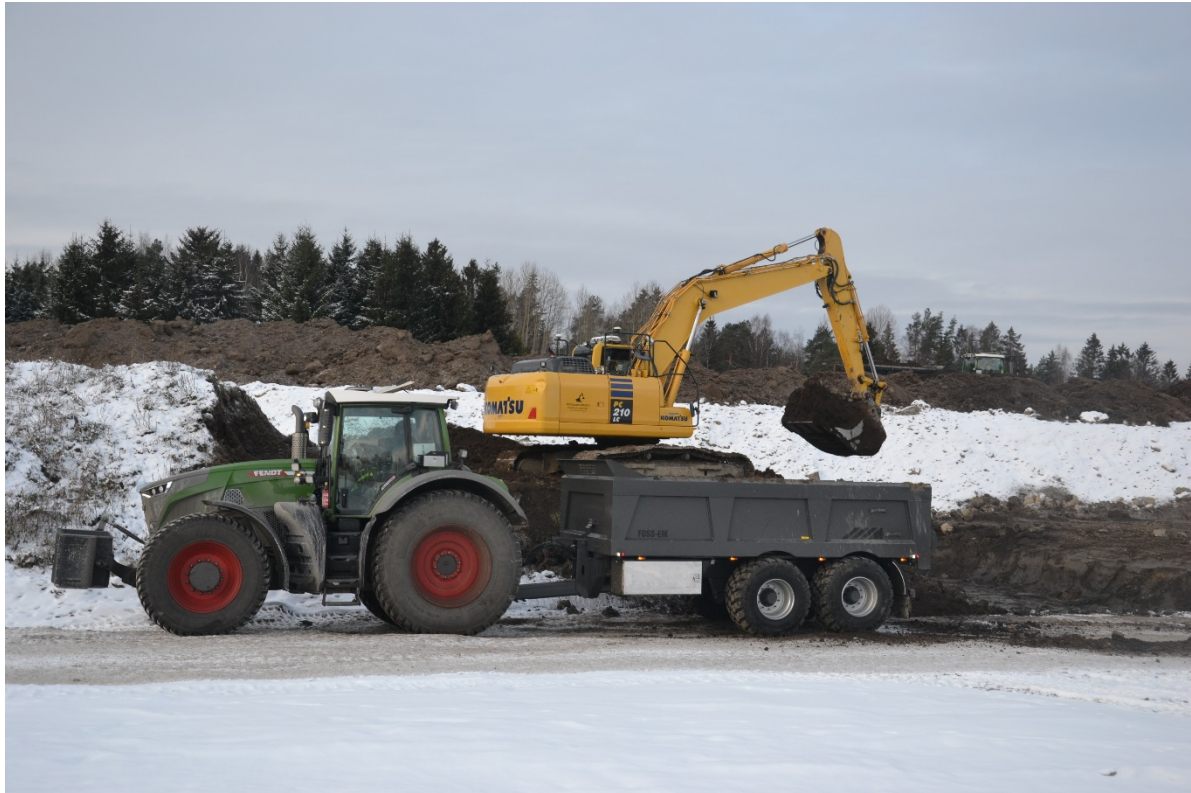
Figur 15. Flytting av A-sjiktstranke på telet jord til utlagt flate med B-sjikt materiale, desember 2021 (Foto: Trond Knapp Haraldsen).
