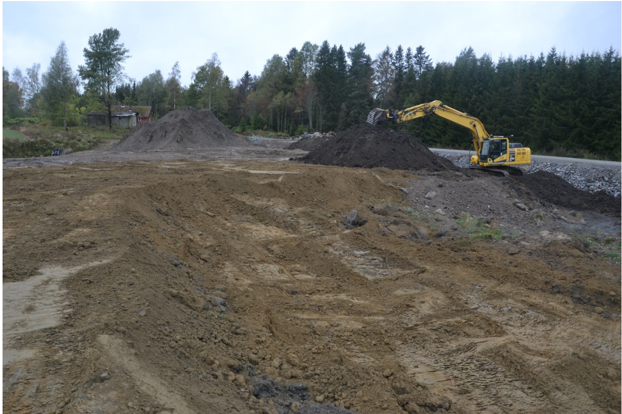
Figur 14. Jorda legges opp med beltegående gravemaskin, slik at en unngår komprimering ved anleggsmaskiner ved utlegging av jord (Foto: Trond Knapp Haraldsen).
