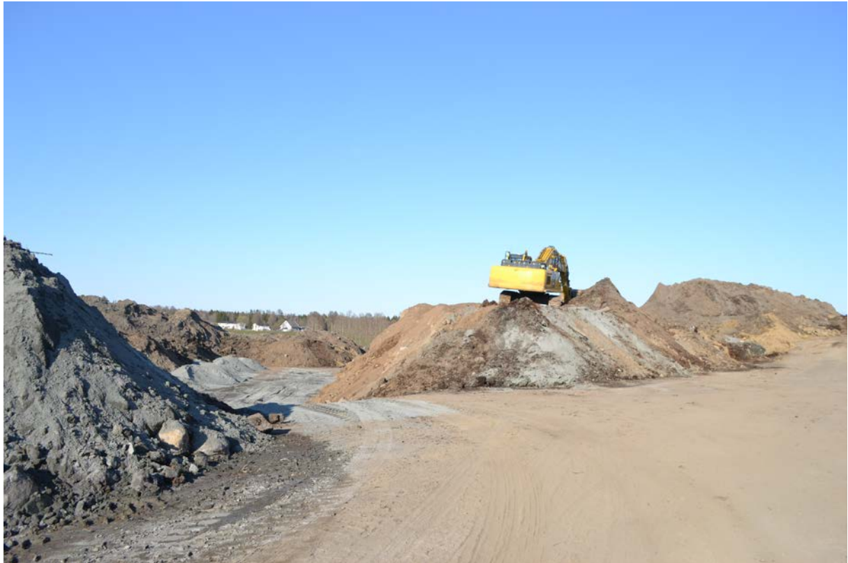
Figur 12. Tillaging av forblandinger for produksjon av anleggsjord basert på naturlige jordmasser av sand, siltig sand, lettleire, steinmel og avvannet torv (Foto: Trond Knapp Haraldsen).
