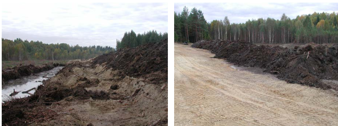
Figur 11. Avvanning av torv tatt direkte fra dyp myr. Fritt vann trekker ned i drenerende sandmasser (Foto: Trond Knapp Haraldsen).
