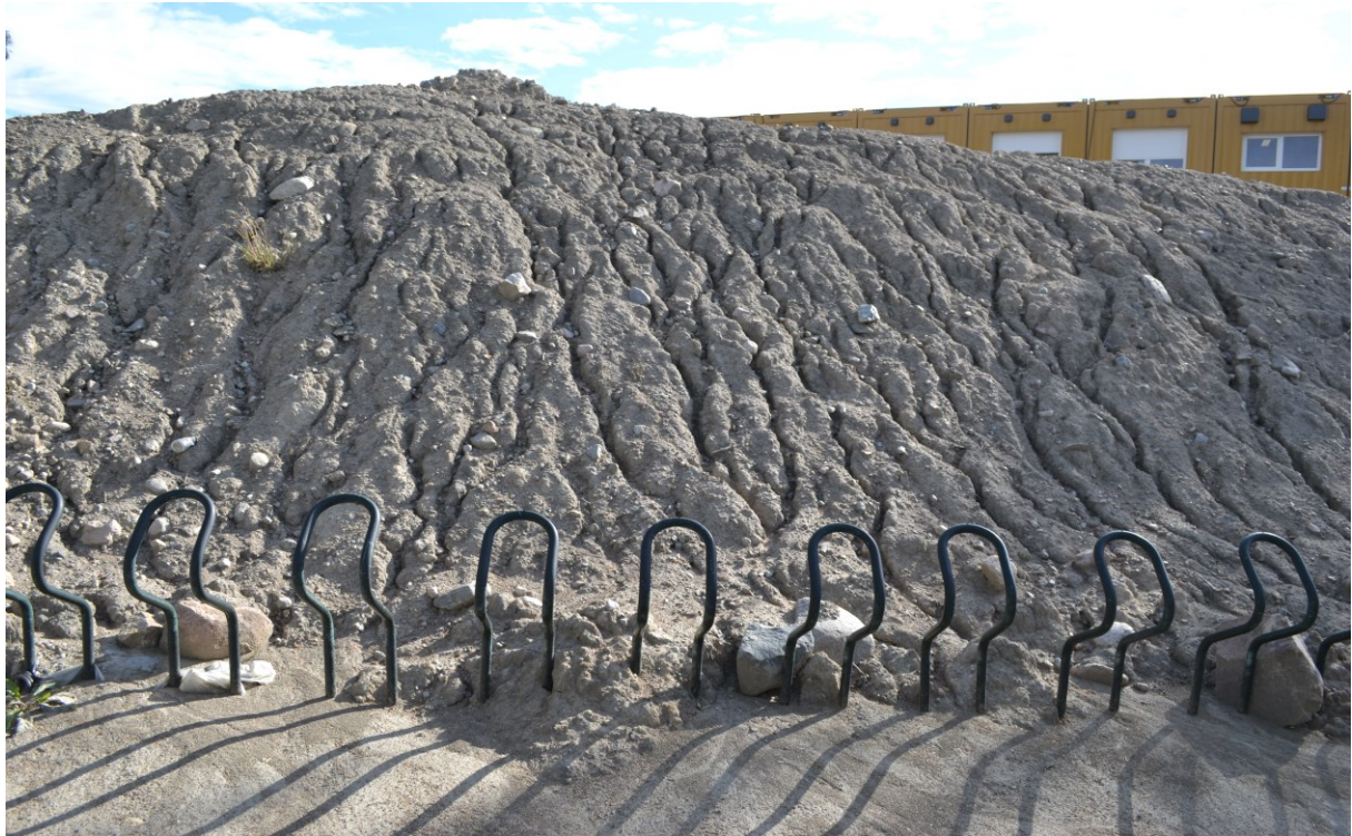
Figur 5. Eksempel på lagring av siltrike jordmasser i ranker som ikke har blitt beskyttet mot erosjon (Foto:Trond Knapp Haraldsen).
