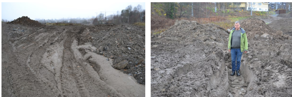
Figur 4. Manglende bæreevne for anleggsmaskiner og dype kjørespor i siltrike masser på masselagringsområde i et utbyggingsprosjekt (Foto: Trond Knapp Haraldsen)
