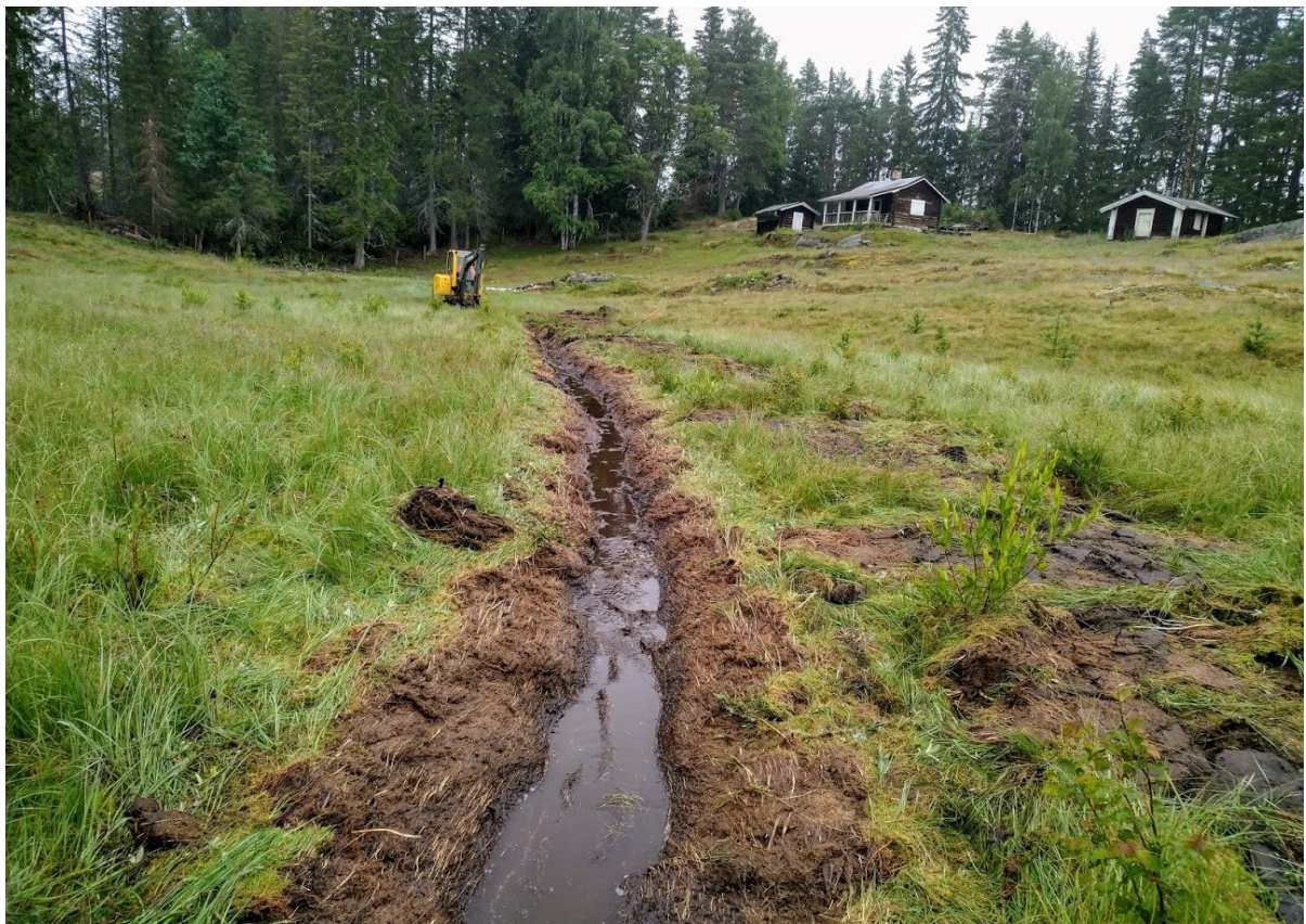
Figur 18. Den gamle grøfta ble restaurert med liten gravemaskin i 2020. Foto ØH 2020.
