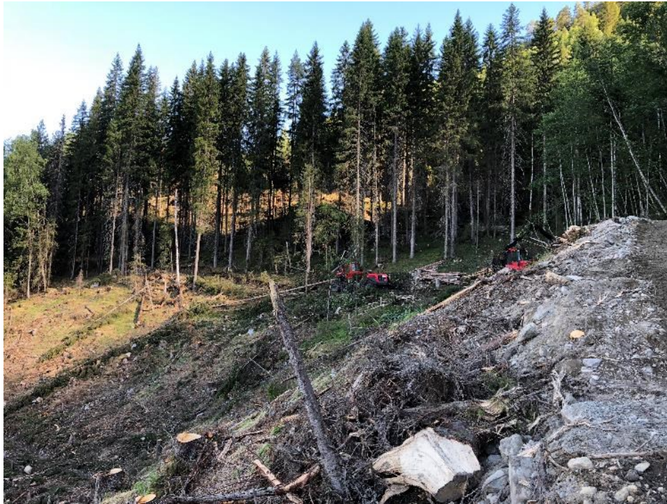
Figur 11. Drift i bratt terreng. Her har en graver utarbeidet driftsveier for å gi skogsmaskinene tilgang til tømmeret på en sikker måte. Foto: Martin Bråthen, Skogkurs.
