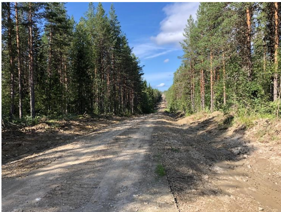
Figur 23. Grøfterensk er nødvendig med jevne mellomrom for å sikre god drenering og opptørking av veikroppen. Grøfting bør alltid gjøres 1-2 år før andre bæreevne-forsterkende tiltak iverksettes. Bilde: Martin Bråthen, Skogkurs.
