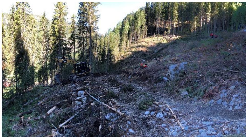
Figur 10. Drift i bratt terreng med assistanse av gravemaskin. Foto: Martin Bråten, Skogkurs.
