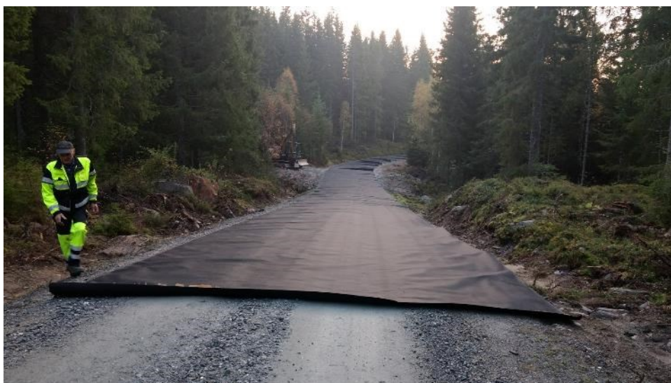
Figur 25. Fiberduk benyttes for å skille eksisterende masser med tilkjørte masser. Blanding av massene gir redusert bæreevne. Bilde Romeriks allmenningene v/ Johannes Enersen.
