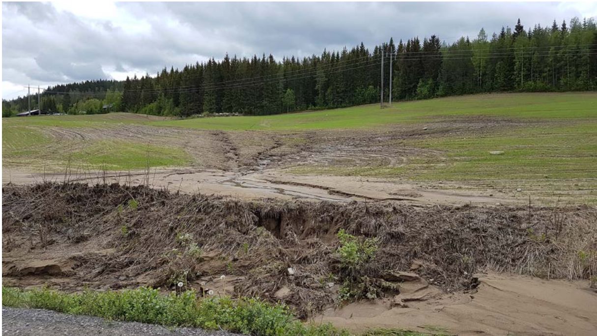
Erosjon på areal med høstkorn. Foto. Ingrid.M. Tenge
