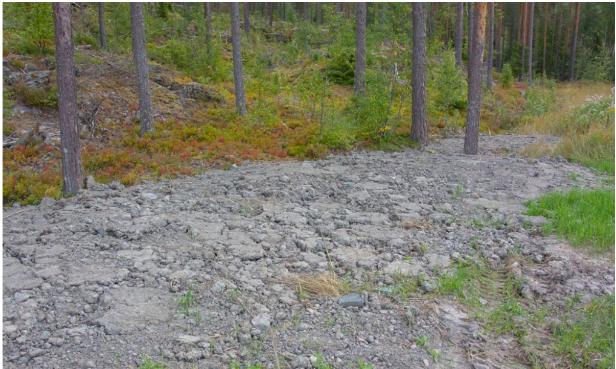
Figur 4. Leire som lå lagret i juni 2022 var i august spredd utover og inn mot kanten hvor det ble sett sprekker i 2021. Pga. tørr sommer har denne leiren sprukket opp og vil derfor ikke tette skikkelig. Dette området bør dekkes med kompost/jord for å hindre uttørking. Foto: Ove Bergersen NIBIO.
