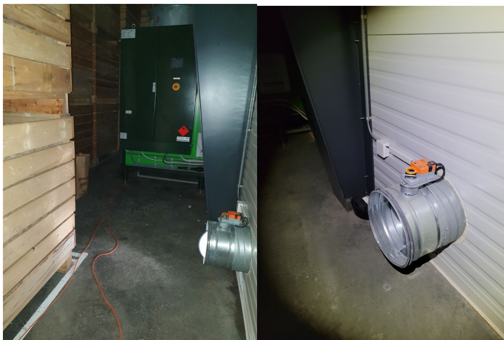
Bilde 18. Liten vifte plassert ved bakveggen i gulvhøyde i omluft-lager til CO 2 -utlufting. (foto: Pia Heltoft)
