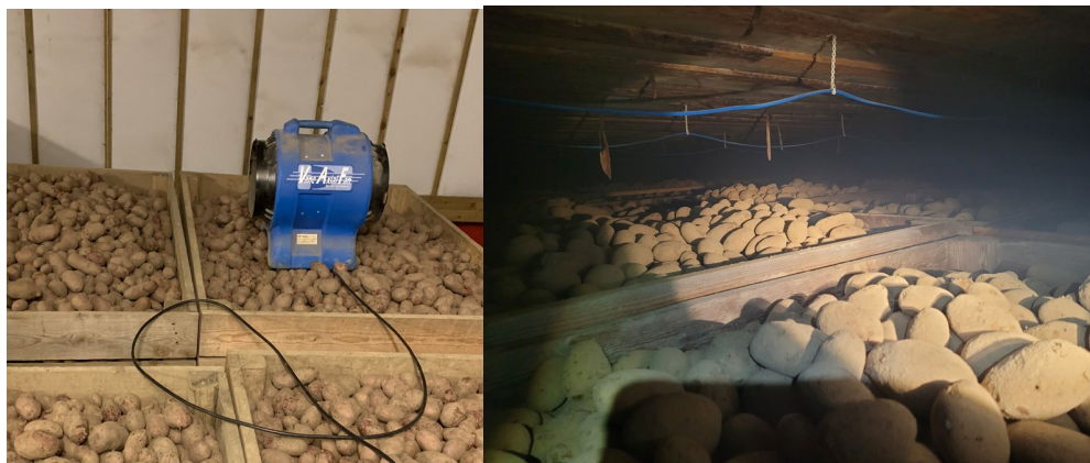
Bilde 12. Stabling av tverrsatte kasser i Findus-lager, tilleggsvifter på toppen og varmekabler under taket over øverste kassehøyde. (fotos: Erlend Indergård og Pia Heltoft)
