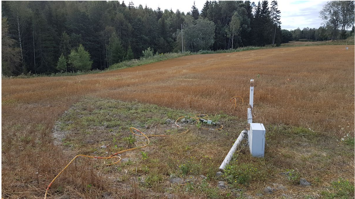
Bilde 4: Målestasjon med datalogger, grunnvannsrør og tensiometere. Foto: Esther Bloem
