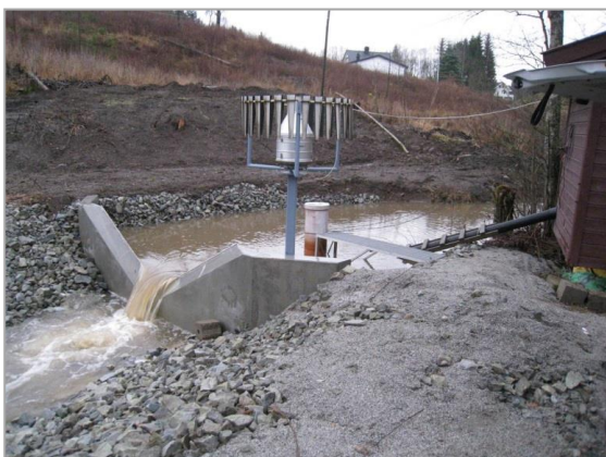
Figur 2. Det nye V-overløpet som ble anlagt i Kolstadbekken i 2012. Nedbørmåleren midt i bildet, målehytta til høyre. Foto: NIBIO.
