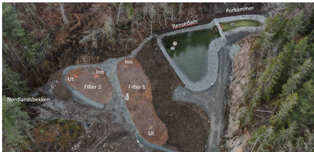
Figur 2. Dronefoto av renseanlegget med forkammer, rensedam og to rensefiltre for nitrogen (Foto: Statens vegvesen).
