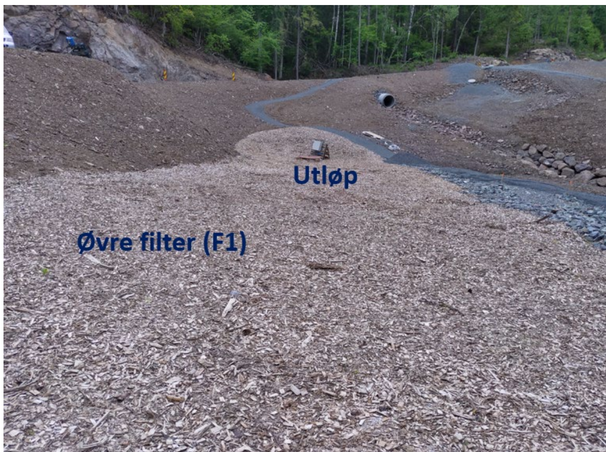
Figur 9. Foto fra innløp mot utløp for øvre filter. Avstanden mellom innløps- og utløpskum er ca. 28 m.
