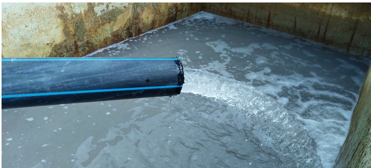
Figur 52. Renset tunnelvann fra Sollihøgdtunnelen som ble anvendt i doseringsforsøket.
