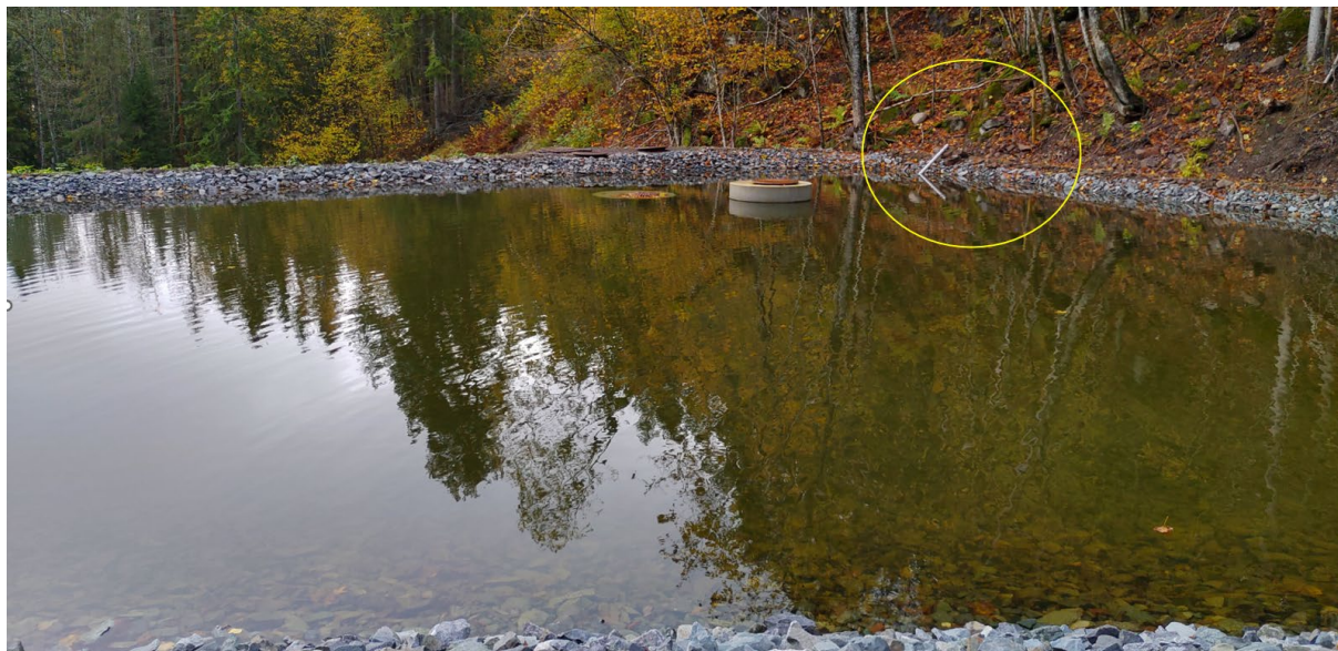
Figur 14. Plassering av automatisk måler DAM ved utløpet av rensedammen (gul sirkel).
