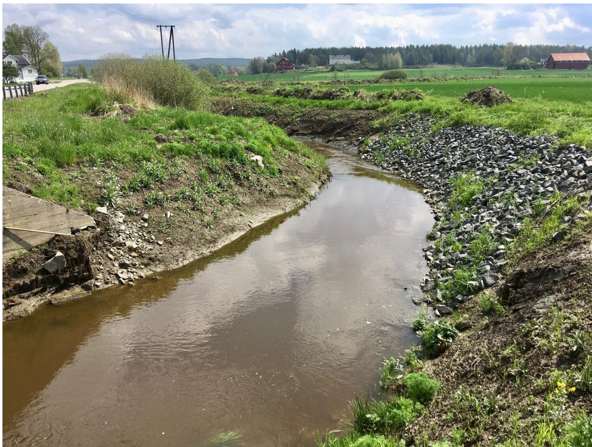
Figur 10: Veidalselva nedstrøms stasjon VEI 4 (003-27942), her ble det 2019 utført oppryddingsarbeid (bildet viser dette fra 2019). Da ble alle vannplanter gravd vekk, elvebunnen senket og kantene fikk slakere vinkel med sprengstein. Materiale fra elvebunn og kanter er lagt langs kanten. Foto: Ruben A. Pettersen
