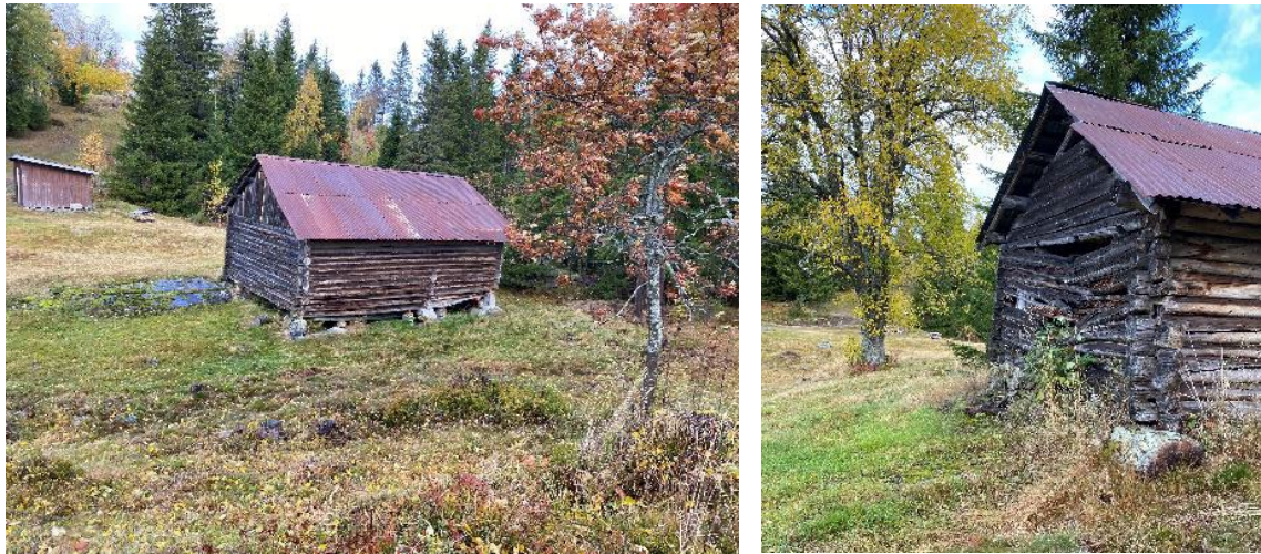
Figur 4: Fjøsset på fjøshaugen ved Søndre Haugplass. Foto: Elin Blütecher 2022.
