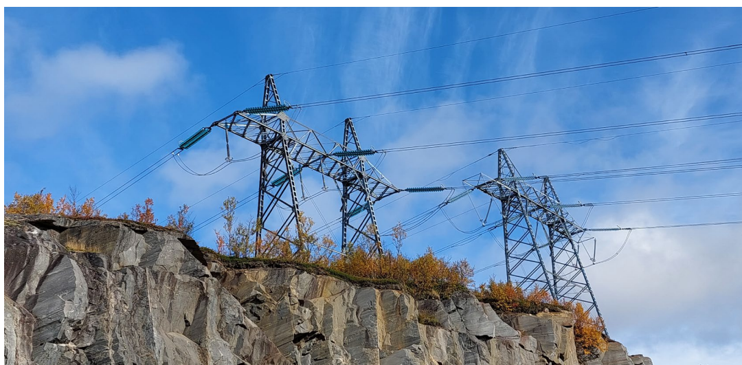
Bilde 5. Det er allerede tekniske inngrep i Hergotområdet. Her representert ved 420 kVh-linjer som passerer gjennom området. Foto: Svein Morten Eilertsen, 20/9-2022.
