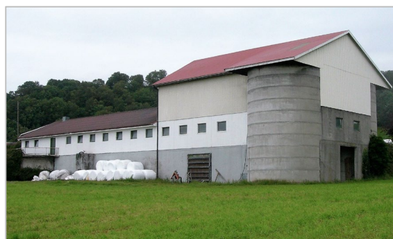
Fjøs. Lavfjøs med gjødselkjeller og fôrsentral med surfôrsiloer. Finnøy i Rogaland 2007. Foto: Olav Balle.
