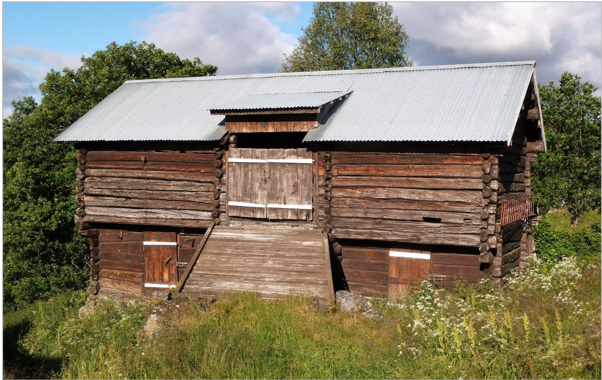
Stall med høytrev fra tida før traktorens inntog. Ål i Buskerud 2017. Foto: Jan Reyer Elders.
