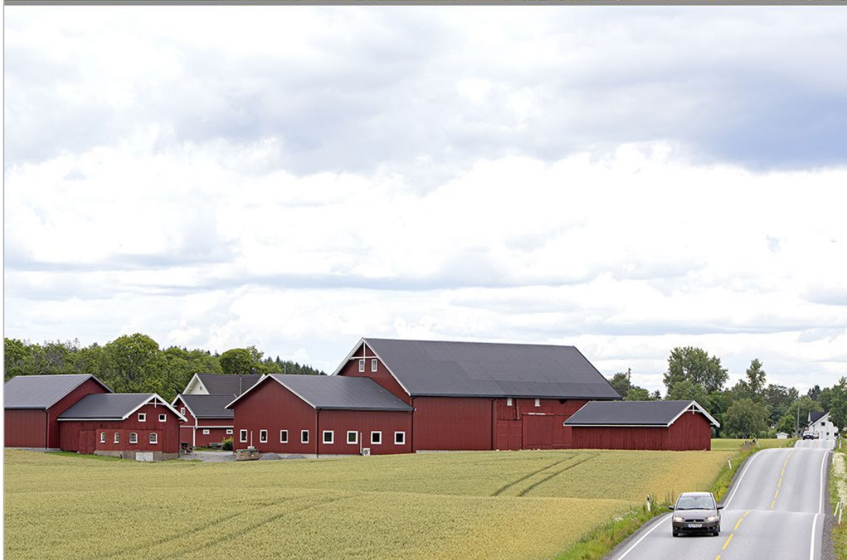
Aktiv drift fordrer til tider justering av bygningsmassen, her ser vi både ombygging og utvidelse. Rakkestad i Østfold. Foto 2008 og 2023: Oskar Puschmann.
