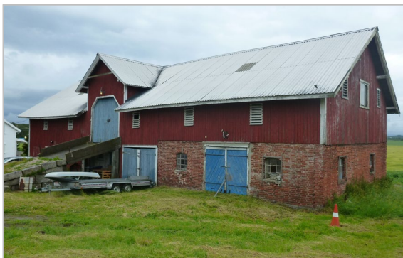
Låve eller enhetslåve med teglverksfjøs, kjørebru og stort høyloft. Fredrikstad i Østfold 2015. Foto: Frode Bentzen.
