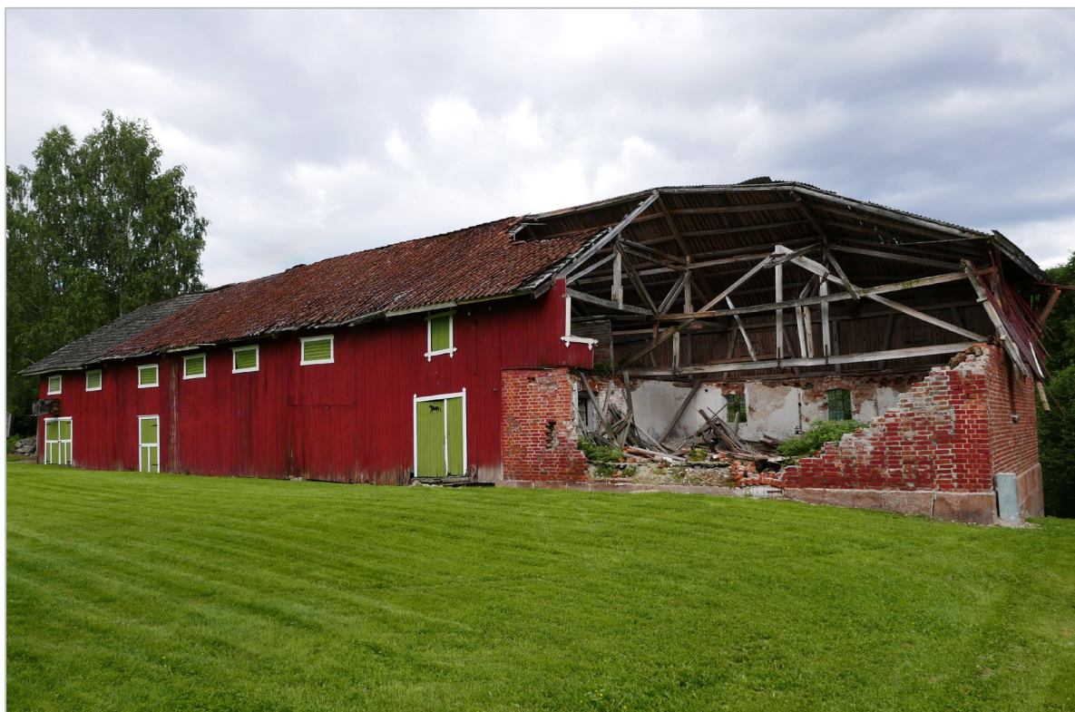
I 3Q-registreringen får denne bygningen tilstandskode «sterkt forfall» og ikke «ruin» fordi bare en mindre del av bygget er sammenrast. Telemark 2017. Foto: Frode Bentzen.
