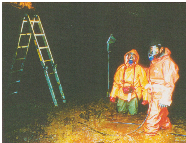
Bilde 5 Gå aldri inn i kjelleren alene uten tilsyn av andre som kan bistå dersom noe skulle gå galt. Ta alltid en kalibrert gassmåler med. Sørg for å ha tilgang på godt nok arbeidslys. Det trengs for å kunne gjennomføre arbeidet nøyaktig nok, og det reduserer risikoen for uhell og ulykker. Foto: Tore Wiik
