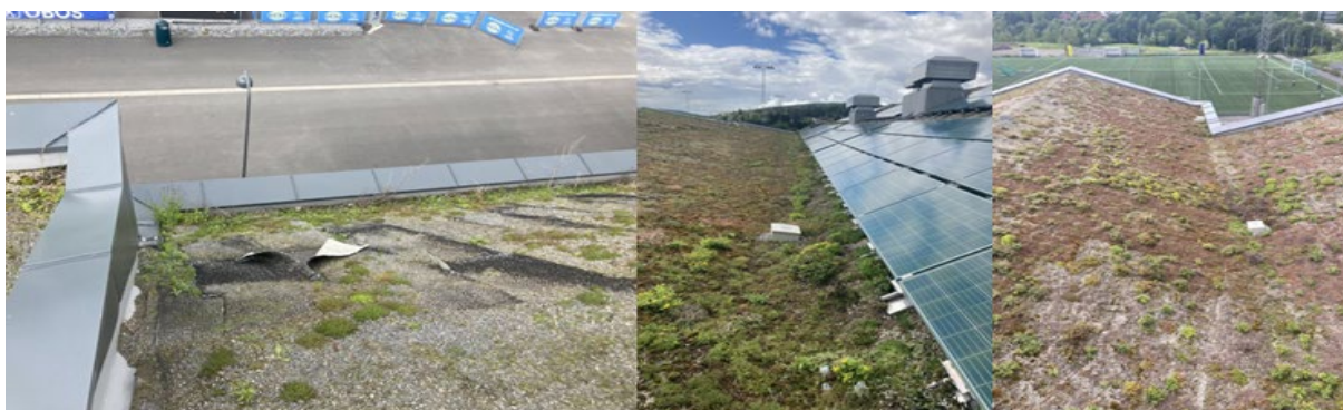
Figur 7. Grorud flerbrukshus, august 2023. Løse dreneringslag og vekstmasser (til venstre), Sedum i takdalen (i midten) og Sedumvekst vest på taket (til høyre). Foto: Lina M. Gunvaldsen/Over Easy Solar.
