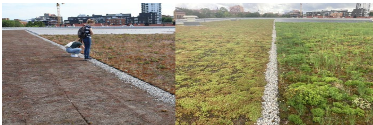
Figur 12. Jordal Amfi ved befaring juni 2023 (til venstre) og august 2023 (til høyre). Kassettløsning er plassert til høyre og sedummatter til venstre på hvert av bildene. Foto: Lina M. Gunvaldsen/Over Easy Solar.
