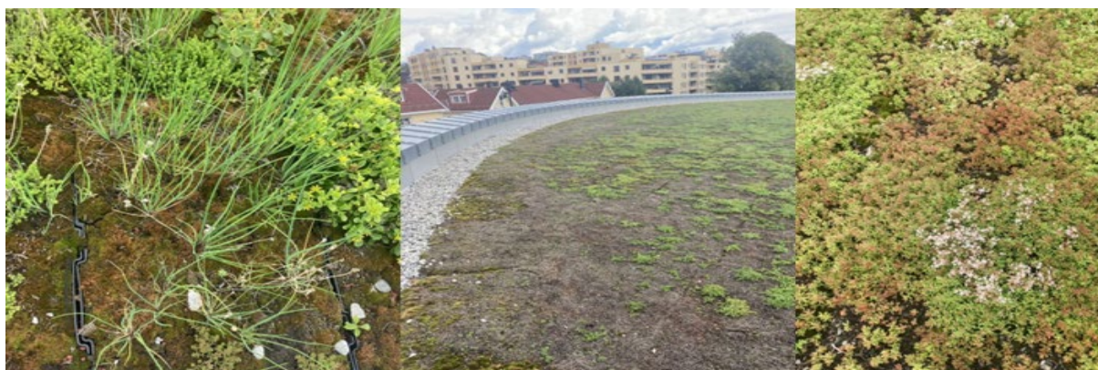
Figur 13. Jordal Amfi August 2023. Mose i sedumkassett (til venstre), tørre områder (i midten) og tett sedumvekst i mattene (til høyre). Foto: Lina M. Gunvaldsen/Over Easy Solar.
