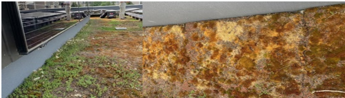
Figur 2. Gransletta barnehage. Blomstring i skyggen av veggen (til venstre) og mosevekst og eksponerte mattekanten (til høyre). Foto: Lina M. Gunvaldsen/Over Easy Solar.
