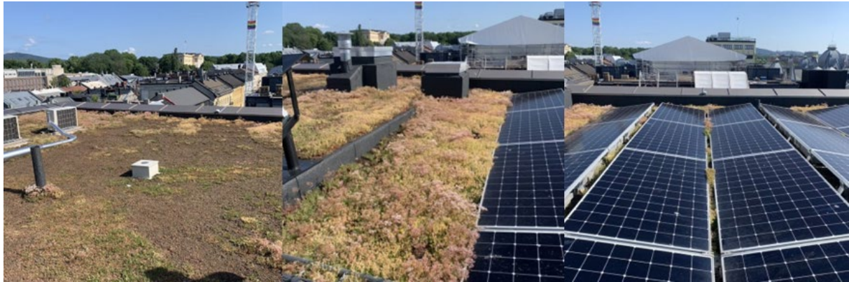
Figur 24. Ruseløkka skole. Område uten frodig vekst (til venstre), frodig sedumvekst (i midten) og Sedum mellom panelene (til høyre). Foto: Lina M. Gunvaldsen/Over Easy Solar.
