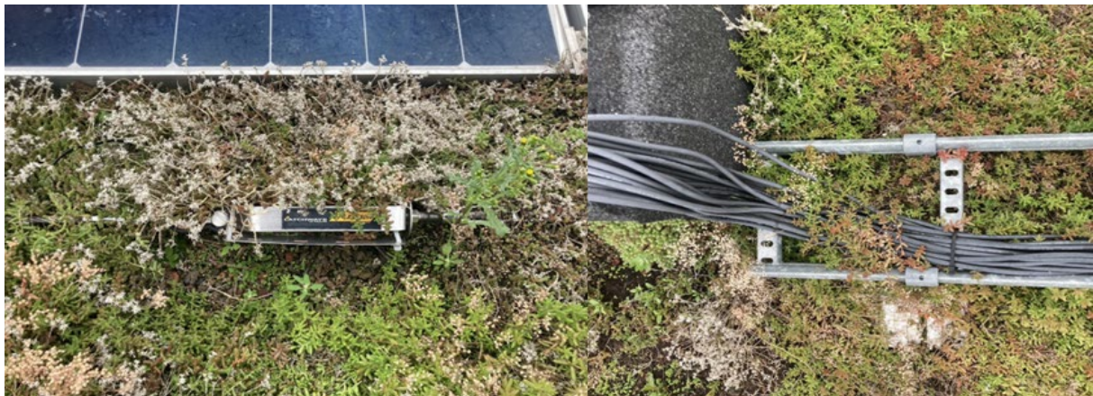
Figur 26. Ruseløkka skole. Koblingsvaier tildekket av sedum (til venstre) og kabelbro med sedumvekst (til høyre). Foto: Lina M. Gunvaldsen/Over Easy Solar.
