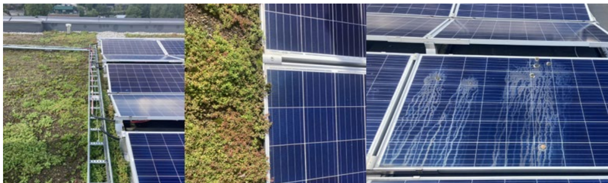
Figur 31. Solfjellshøgda helsehus. Utildekket kabelbro (til venstre), begynnende skyggelegging fra sedum (i midten) og tilsnussede paneler (til høyre). Foto: Lina M. Gunvaldsen/Over Easy Solar.
