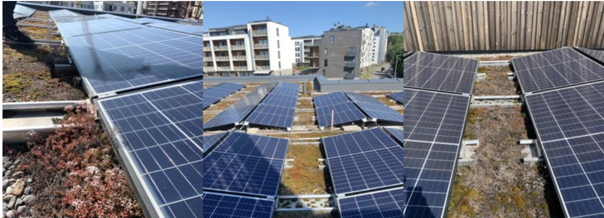
Figur 33. Vollebekk barnehage. Blomstring under paneler (til venstre), mosevekst mellom og under paneler (i midten) og tørre områder (til høyre). Foto: Lina M. Gunvaldsen/Over Easy Solar.
