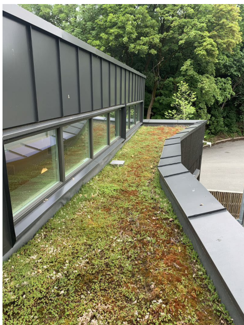
Figur 9. Hasselhaugen barnehage. Den største sammenhengende flaten med sedumdekke. Foto: Lina M. Gunvaldsen/Over Easy Solar.
