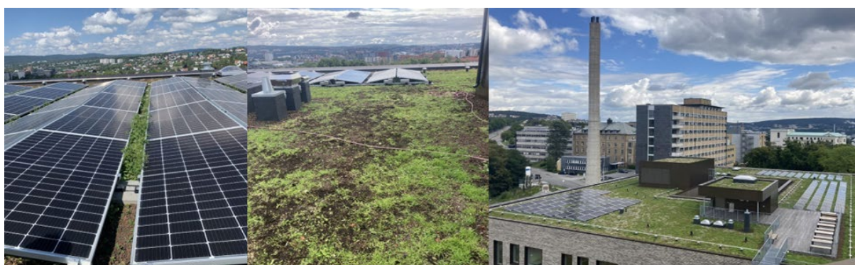
Figur 36. Storbylegevakten, august 2023. Ugress mellom panelene (til venstre), området med sedumdød (i midten), gjengrodd slitasjesti i august (til høyre). Foto: Lina M. Gunvaldsen/Over Easy Solar.
