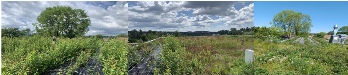
Figur 21. Munkerud miljøbarnehage 6 juni. Nordlige halvdel av taket (til venstre), sørlige halvdel av taket (i midten), og nordlige halvdel til høyre. Foto: Lina M. Gunvaldsen/Over Easy Solar.
