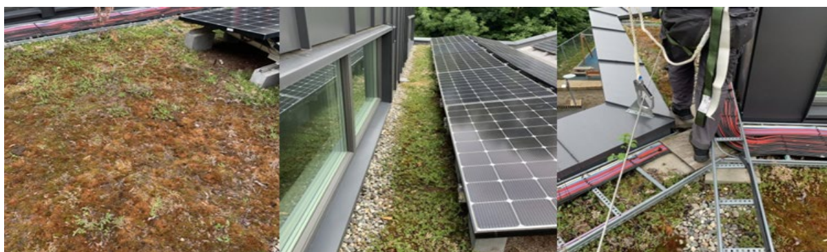
Figur 10. Hasselhaugen barnehage. Mosevekst i sedumdekket (til venstre), blomstring i skyggen (i midten) og område med snublefarer (til høyre). Foto: Lina M. Gunvaldsen/Over Easy Solar.
