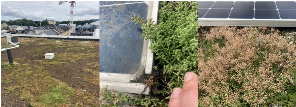
Figur 25. Ruseløkka skole, august 2023. Område med minst frodig vekst (til venstre), Sedum voksende på panel (i midten), og avblomstret sedum (til høyre). Foto: Lina M. Gunvaldsen/Over Easy Solar.
