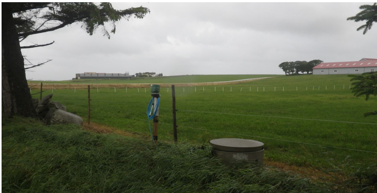
Figur 17. Grunnvannlokaliteten Horpestad Brønn sommeren 2021 (Vann-ID 91949). Foto: Bertinius Brattebø.
