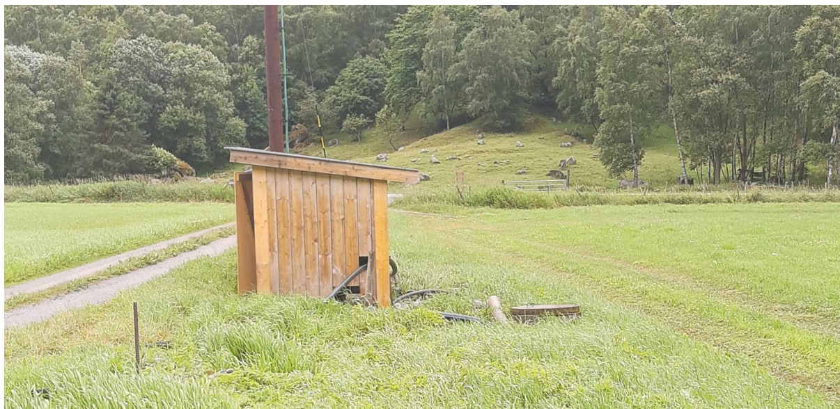
Figur 14. Viser Lærdal Vanningsbrønn sommer 2020 (Foto: Charles H. Carr).
