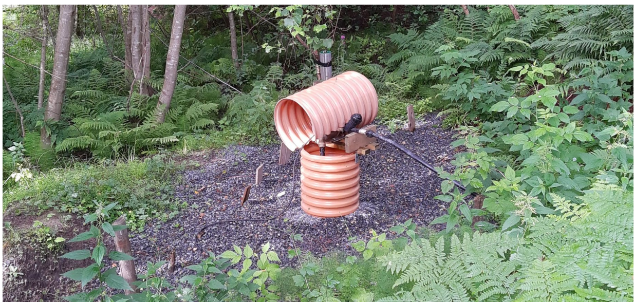
Figur 10. Gruskastet kum etablert for vanning av bringebær på Knipkil gård (Foto: Charles H. Carr).
