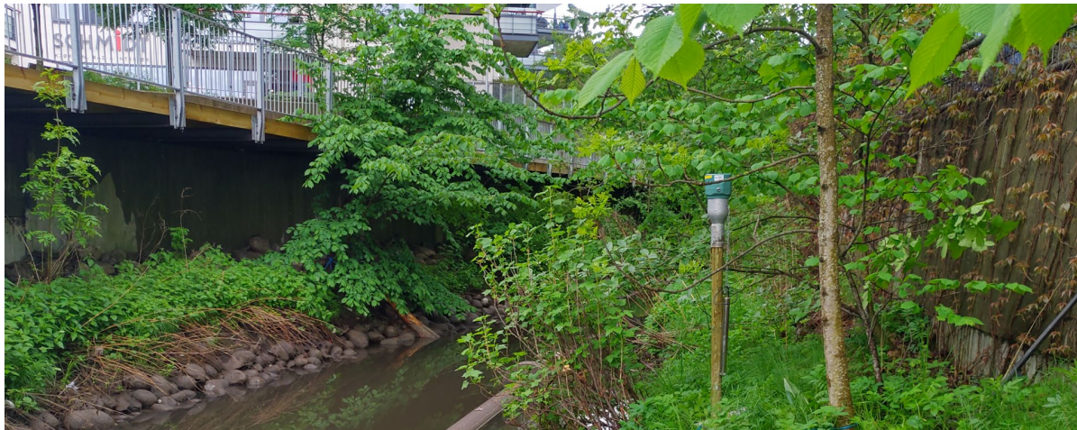
Figur 2. Referansestasjon SJØ-O i Hoffselva oppstrøms kulvertarbeidene, 23.05.23 (Foto: Roger Roseth).
