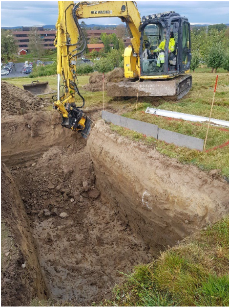
Figur 8: Venstre: Utgraving av grøfter langs og foran gravemaskin. Høyre: Oppsamlingsrør installert horisontalt inn fra sidene på forsøksrutene for å samle opp vann som infiltrerte ned gjennom jordprofilen.
