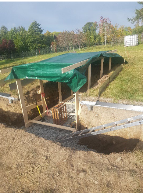
Figur 9: Forskaling ble bygget for å hindre at veggene i målegroft med mer sandig jord skulle skli ut i tilfelle store nedbørsmengder. Dette ble ikke vurdert nødvendig i grøfta med mer leirholdig jord.
