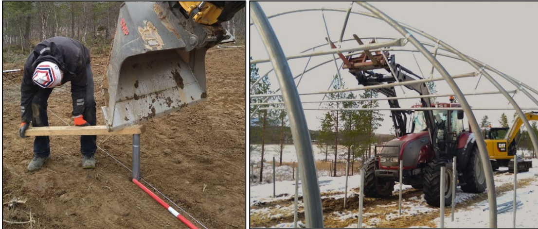
Bilde 4. Nedsetting av forankringsrør for tunnelbuene. Rørene kan trykkes ned med gravemaskin hvis det er steinfri mark. T.h: Buene løftes på plass parallelt med bordstolpene. Foto: Kristin Sørensen
