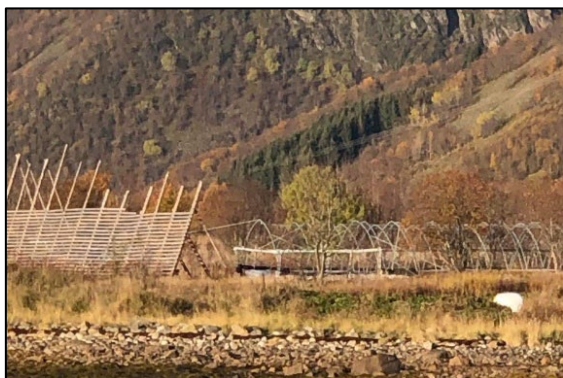
Bilde 1. Levegg i forkant av tunnel på Stokmarknes. Foto: Svein Sivertsen
