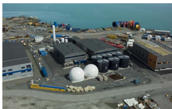
I biogassanlegget RENEVO på Stord lages det biogass og biorest av husdyrgjødsel, matavfall og fiskeensilasje. Bilde: RENEVO
